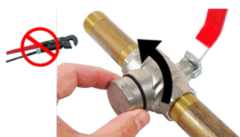
Obr. 7 - vyjmutí filtračního sítka
